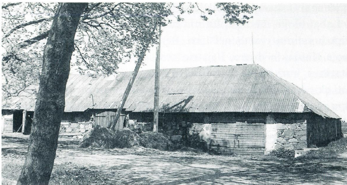
18 pav. Kaulakio dvaro sodybos akmenų mūro diendaržinis tvartas (abarės). D. Puodžiukienės nuotr. 1992 m.
