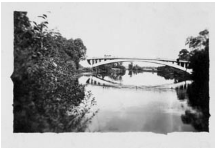
Paliūniškio tiltas. 1938 m. rugpjūčio 14 d.
