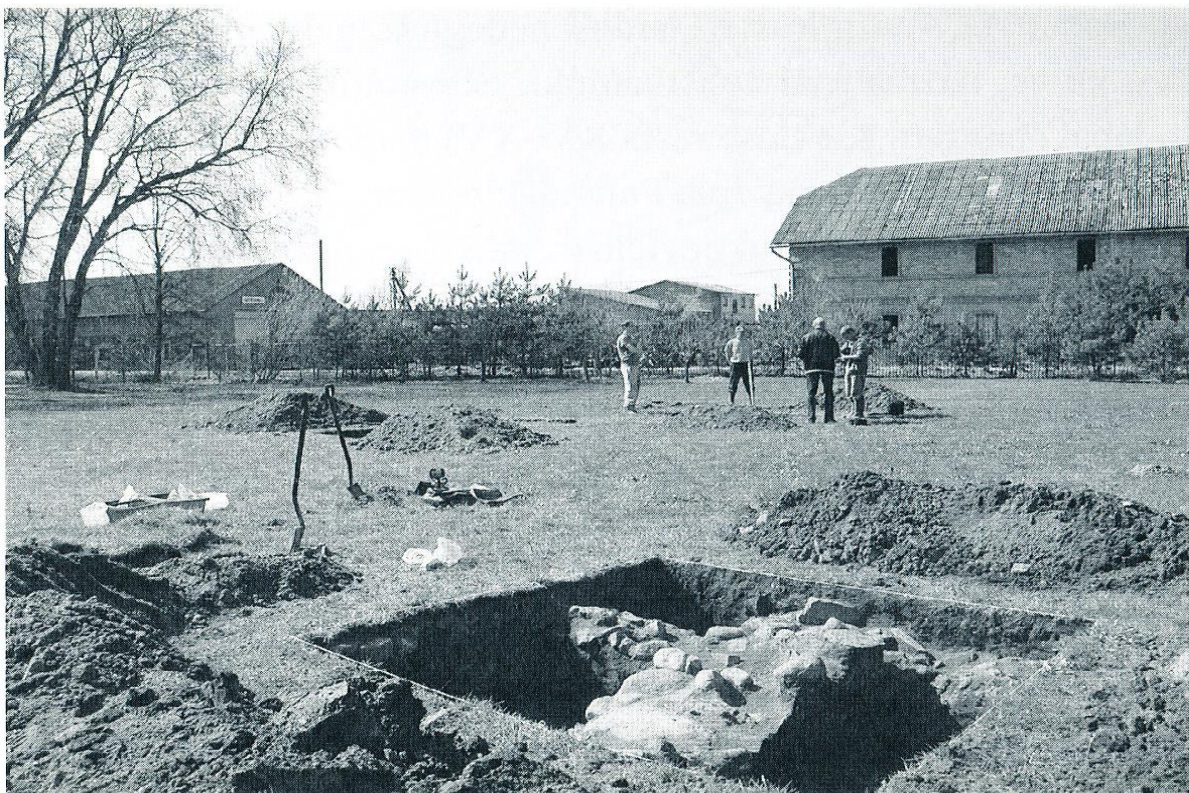
Šurfe 2 atidengtas akmeninis pagrindinio dvaro pastato pamatas, vaizdas iš šiaurės rytų pusės, lauko darbai. D. Petrulio nuotr. 2014 m.
